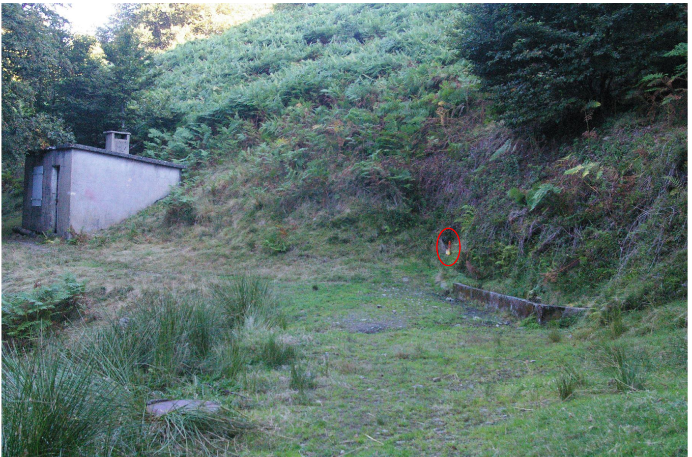
Lieu de positionnement de la balise.
